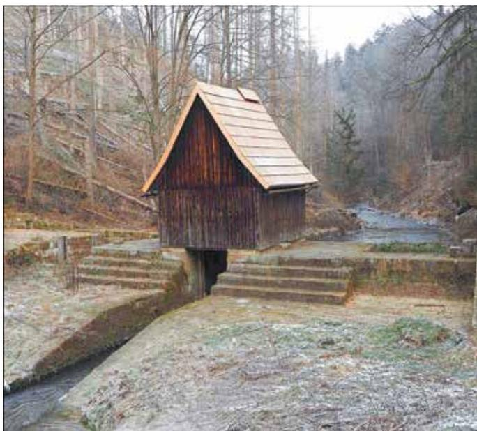
Das unscheinbare kleine Haus ist der Wetterschutz für die Stauvorrichtung der Niederen Schleuse, die so stabil ausgelegt ist, dass sie schon viele Hochwasser in der Kirnitzsch überstanden hat. Dank des funktionsfähigen Zustands der Niederen Schleuse konnten Mitarbeiter der Nationalparkwacht während des Waldbrandes im August 2022 die Kirnitzsch an der Niederen Schleuse vorsorglich anstauen, um einen ausreichenden Löschwasservorrat mit Saugstelle einzurichten. Foto: F. Strohbach
